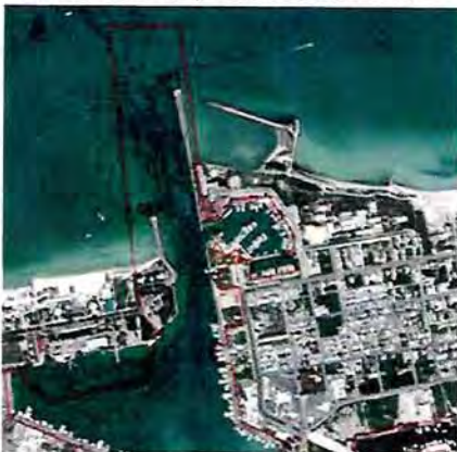
Figura 39 Obras de protección del Recinto Portuario de Yucalpetén
