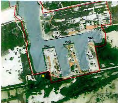
Figura 35 Obras de atraque del Recinto Portuario de Sisal
