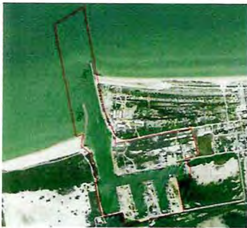
Figura 34 Obras de protección del Recinto Portuario de Sisal
