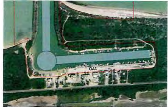
Figura 43 Obras de atraque del Recinto Portuario de Chabihau
